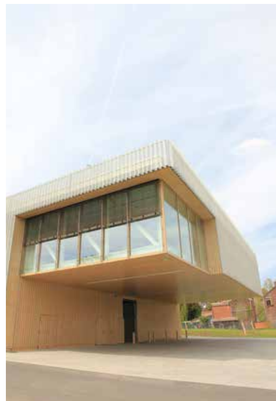
Photo de 2019, après les travaux.
