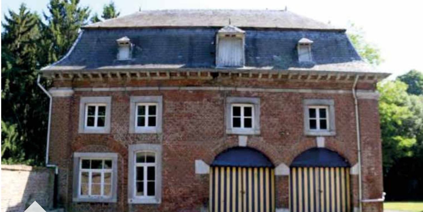
La maison du garde
